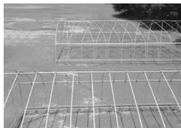
写真3 トラスハウス(奥)と従来ハウス(手前)の構造の違い
